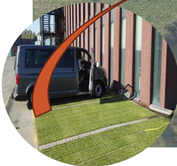
Ontharde parking + waterzuivering + hergebruik
